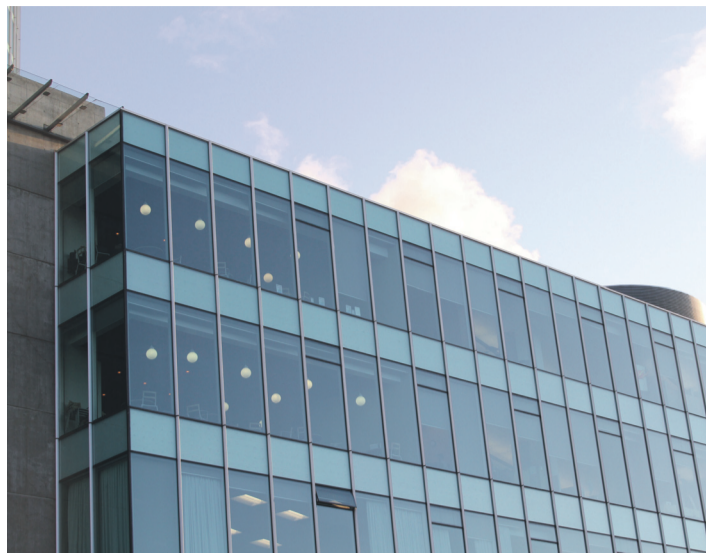
Firma dua Košičanov spravovala kancelárske priestory.
